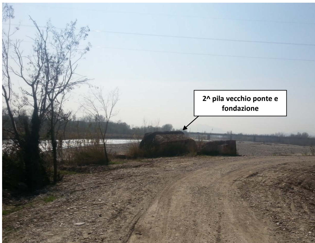
Foto 2: fondazione e parte della seconda pila del vecchio ponte
